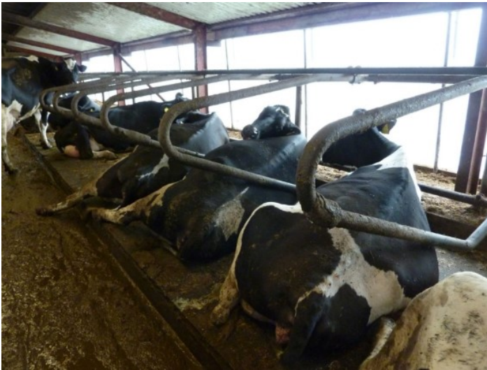
Figur 25. Når køerne endelig kommer ned at ligge, ligger de således. Forklaringen på problemerne er, at køerne slet ikke kan udnytte sengebåsenes ekstra længde, fordi frontrøret og betonhovedpuden er i vejen for dem, når de skal ned og ligge. Desuden er nakkebommen for lav og for langt tilbage.
