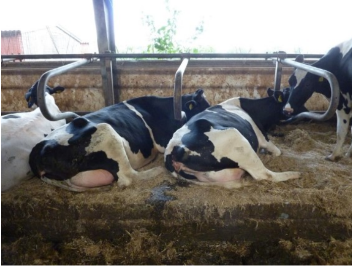
Figur 13. Disse senge er bygget om til kummer med halm-kalk-vand ved at forhøje bagkanten. Billedet viser tydeligt, at sengebåseindretningen ikke er ideel. Et frontrør, en ydervæg lige op af sengene og en nakkebom som sidder lidt for lavt og for langt tilbage, er årsag til at disse køer ligger på skrå og skider i sengene.
