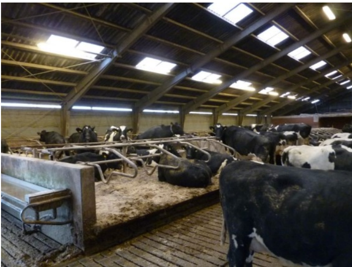
Figur 9. Sengene er lavet om til kummer med halm-kalk-vand ved at forhøje bagkanten med en skrå bagkant. Køerne har fået et blødere underlag at ligge og stå i, men ellers er forbedringerne begrænset. Som billedet viser, er køerne heller ikke helt tilfredse med deres nye senge.
